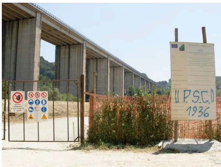
Un depuratore in corso di costruzione da molti anni
